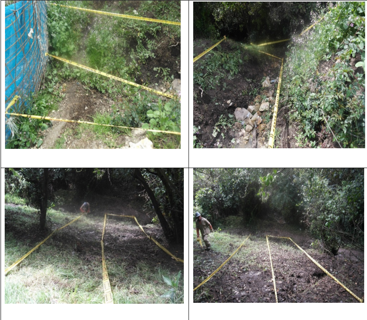
Fotografías 1-4. Franja a intervenir instalacion tubería de descole de aguas lluvias.
