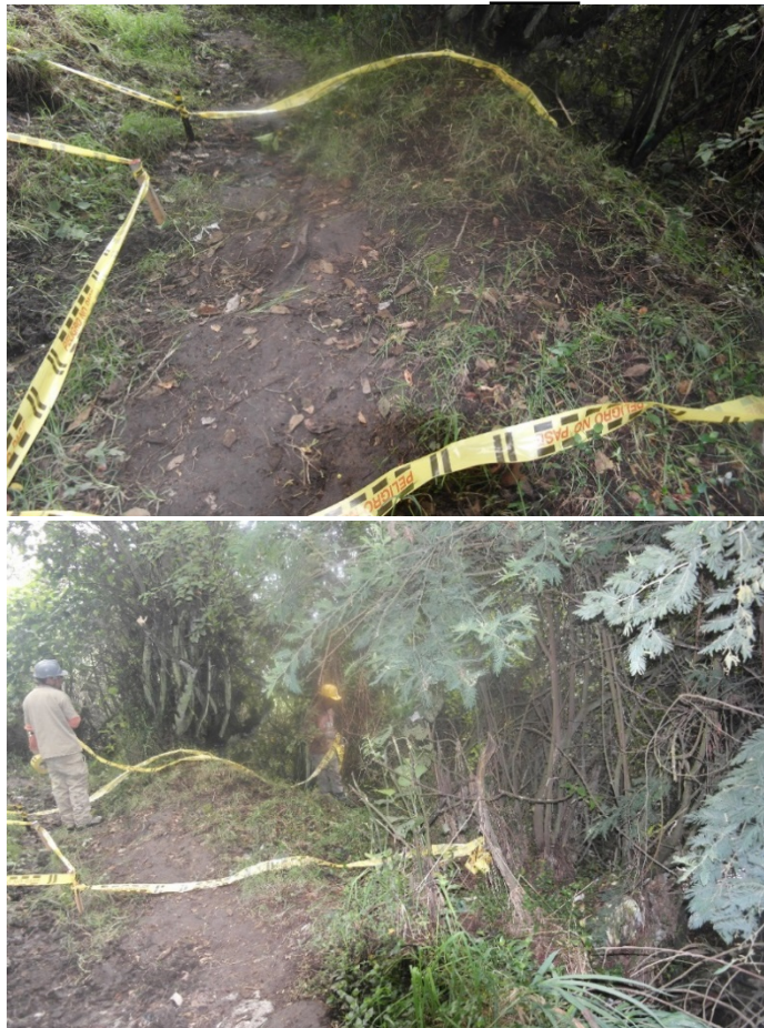
Fotografías 5-6. Area que sera intervenida para la construccion del cabezal.
